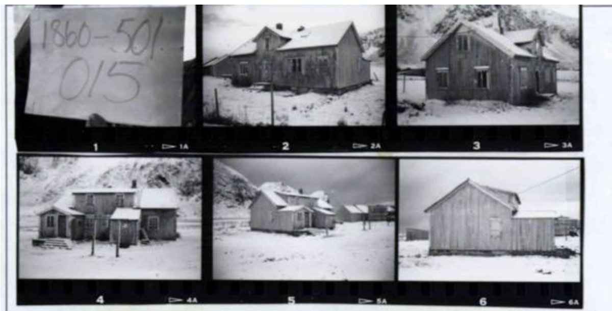
Figur 13 Våningshus (3) bilde fra sefrak registrering og våningshus og fjøs (2) idag. Fjøs i dårlig stand og våningshus i god stand.
