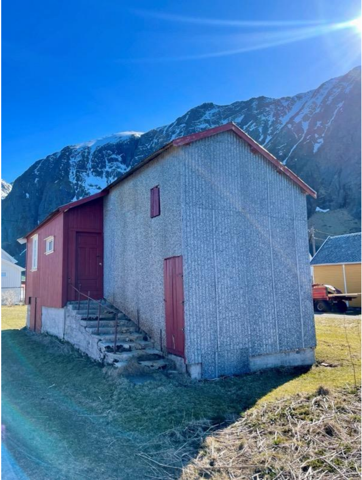
Figur 31. Fjøs og bolig i et bygg på Eggum gir særpreg til kulturmiljøet. Foto: Henriette Crook.
