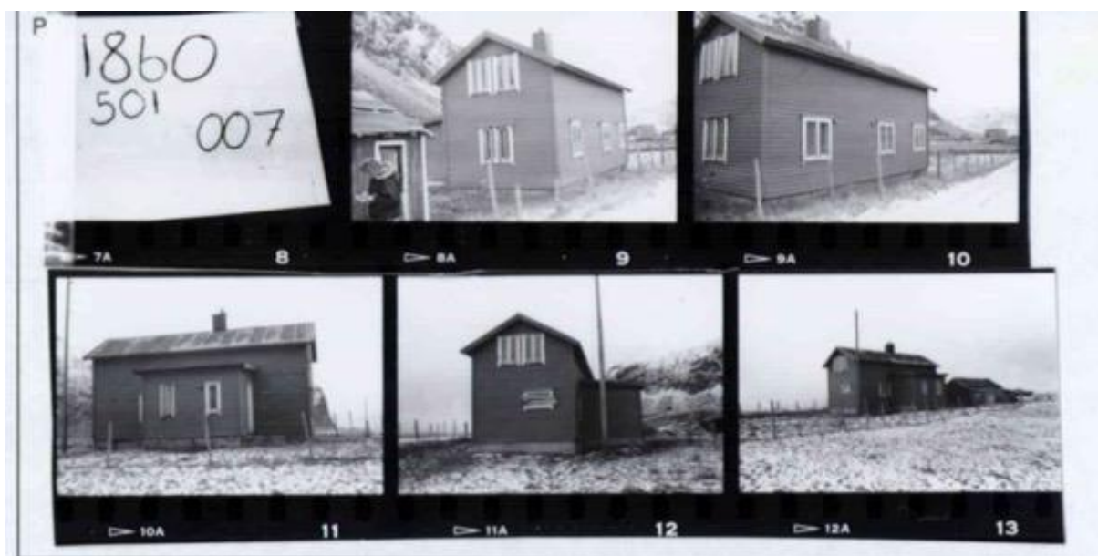
Figur 14 Våningshus (5), bygningsnummer 189571046. Brukes i dag som fritidsbolig.
